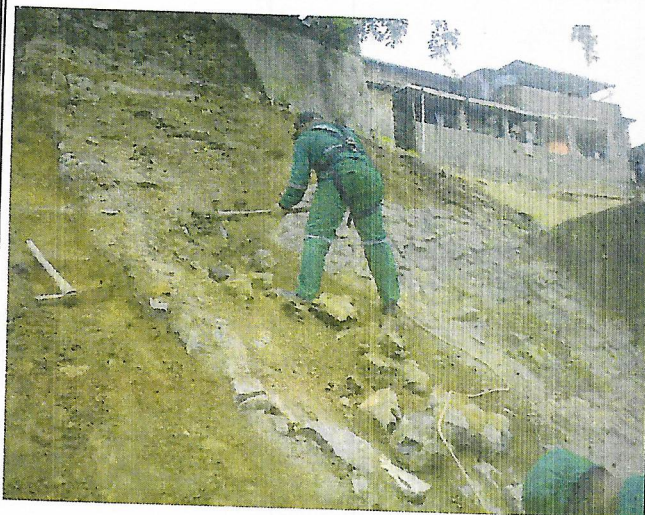
Remoção de Paralelo - Rua 21 de Abril.
