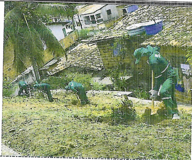
Remoção de raízes - Rua 21 de Abril.
