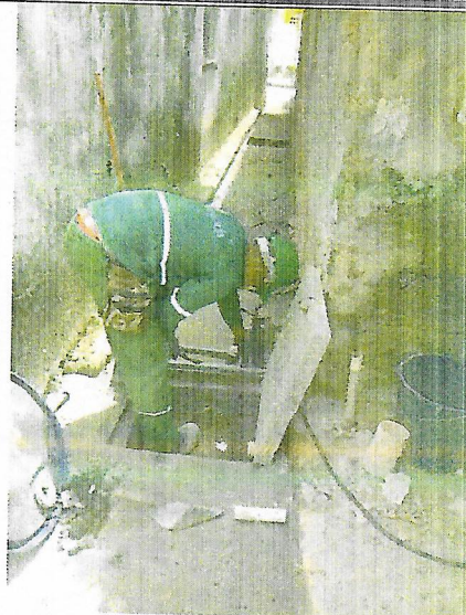
Caixas de Passagem – Rua Santo Antônio.
