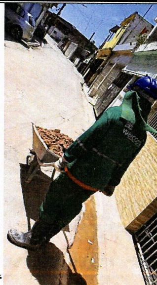
Remoção de material retirado da barreira - Coqueirinho.
