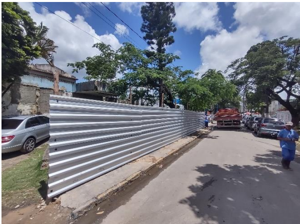
TAPUME EXECUTADO NA FRENTE DA OBRA
