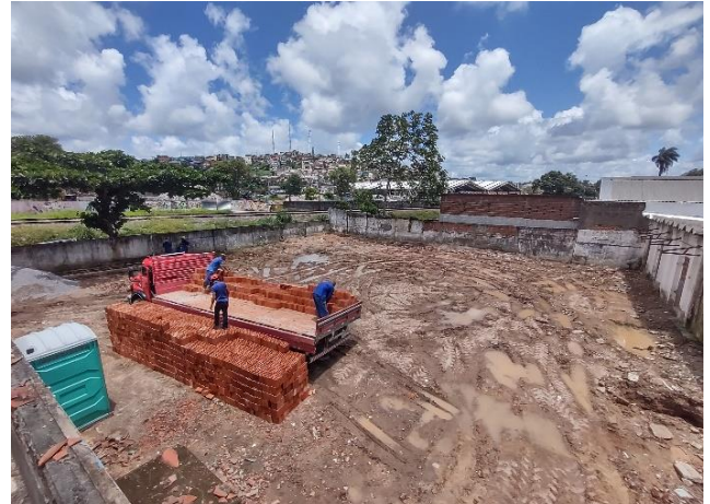
LIMPEZA DA VEGETACAO, REGULARIZACAO DO TERRENO E REMOCAO DE ENTULHO
