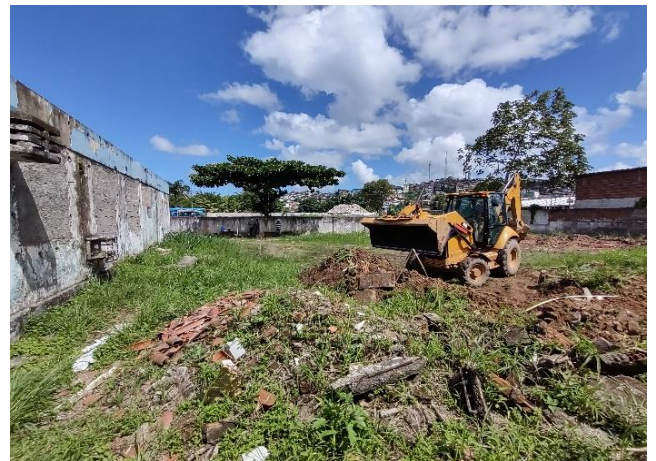
DEMOLICAO DE ALVENARIA, PILARES E VIGAS DE CONCRETO
