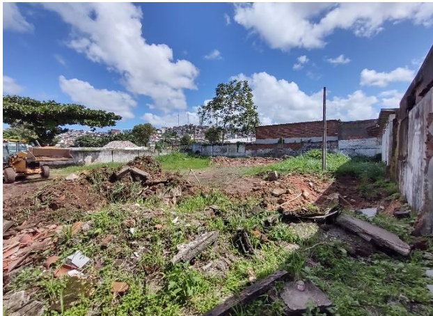
REMOCAO DE POSTE DE CONCRETO ARMADO
