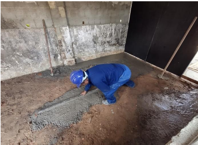
PISO DO ALMOXARIFADO SENDO EXECUTADO
