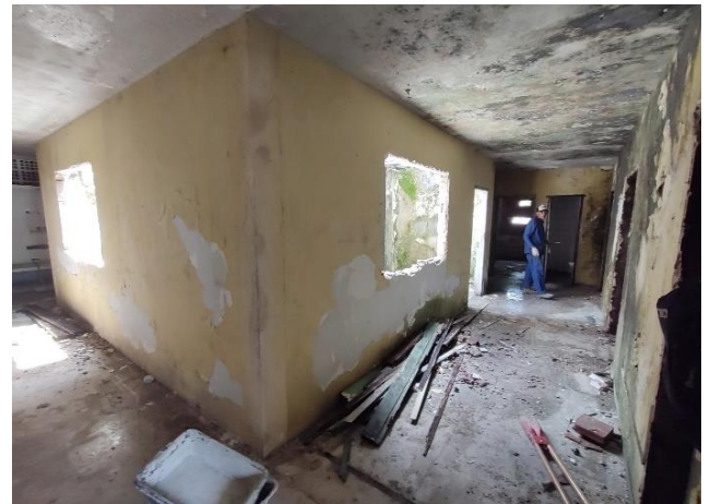
REMOCAO DAS ESQUADRIAS
