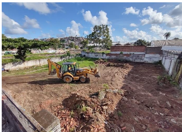
ESCAVACAO PARA DESCARTE EM BOTA FORA
