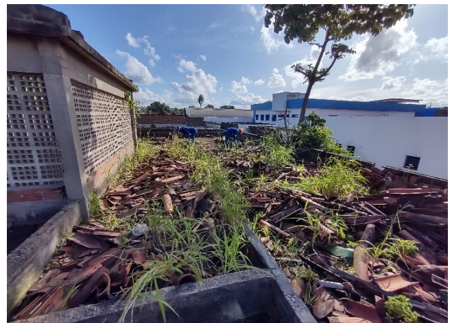
REMOCAO DE MADEIRAS DA COBERTA
