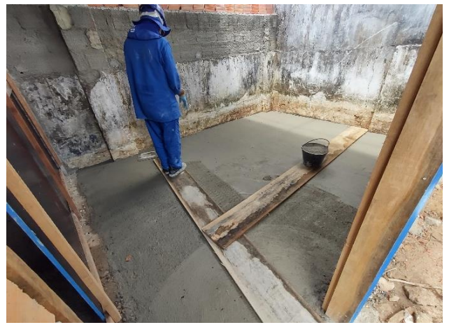
PISO DO DEPOSITO SENDO EXECUTADO
