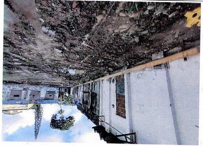
Alvenaria De Vedação De Blocos Vazados De Cerâmica
