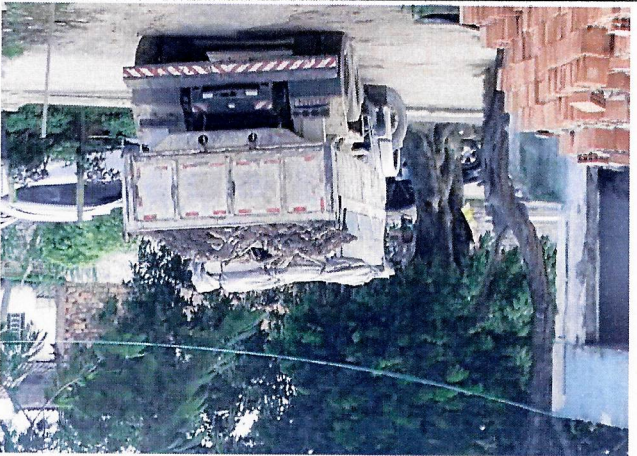
Carga, Manobra E Descarga De Entulho Em Caminhão Basculante 6 M 3 - Carga Com Escavadeira Hidráulica, Transporte Com Caminhão Basculante De 10 M 3 e Destinação de material
