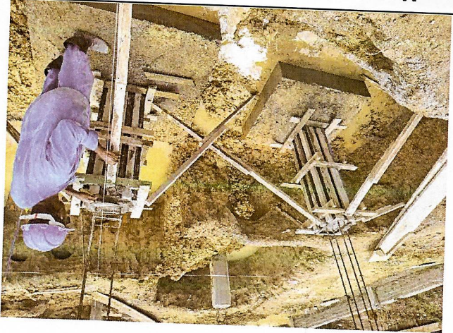
Montagem E Desmontagem De Forma De Pilares Retangulares E Estruturas Similares, Pé-Direito Simples, Em Chapa De Madeira Compensada Resinada, 6 Utilizações.
