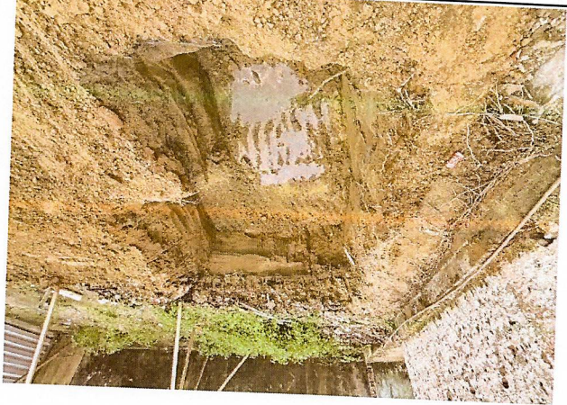
Escavação Manual Para Bloco De Coroamento Ou Sapata, Com Previsão De Forma. Reservatório inferior - (Volume da escavação com um acréscimo de 0,40cm para cada lado e 0,10cm na profundidade)
