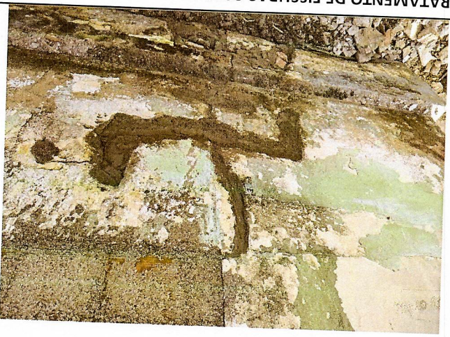
TRATAMENTO DE FISSURAS COM ARGAMASSA DE CIMENTO E AREIA TRAÇO 1:3 (SEÇÃO ATÉ 5 X 5 CM) E Paredes externas e internas
