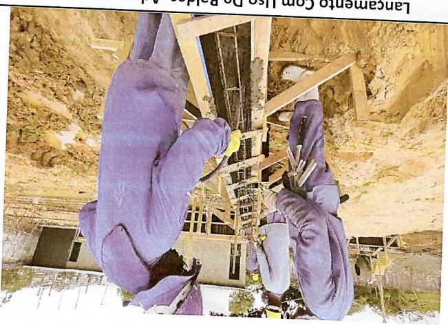
Lançamento Com Uso De Baldes, Adensamento E Acabamento De Concreto Em Estruturas.
