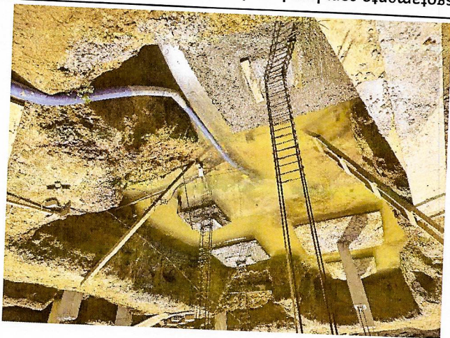
Esgotamento com bomba submersível elétrica trifásica acima 2 ate 5 CV, inclusive gerador.
