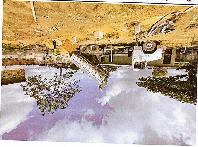
Carga, Manobra E Descarga De Entulho Em Caminhão Basculante
