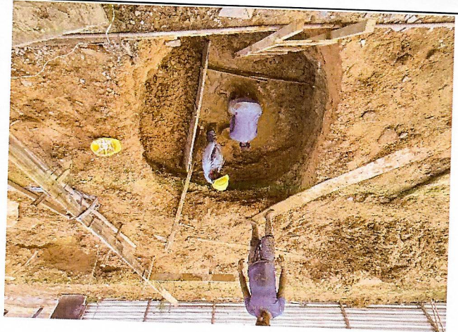
Escavação Manual Para Bloco De Coramento Ou Sapata, Com Previsão De Fôrma. (Filtro)
