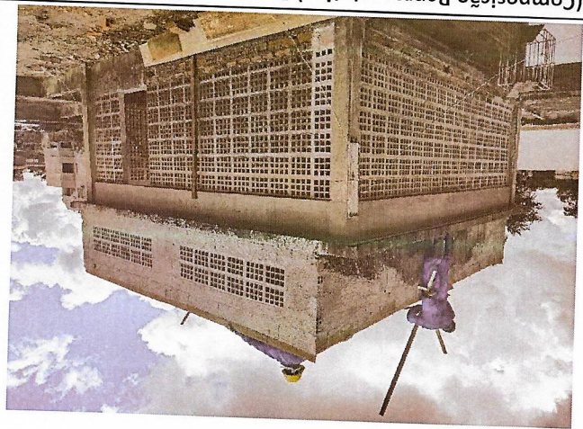
(Composição Representativa) Do Serviço De Alvenaria De Vedação De Blocos Vazados De Cerâmica De 9X19X19Cm (Espessura 9Cm) Coberta parte central elevacao para realizar a adequacao das 4 aguas do telhado prevista no projeto
