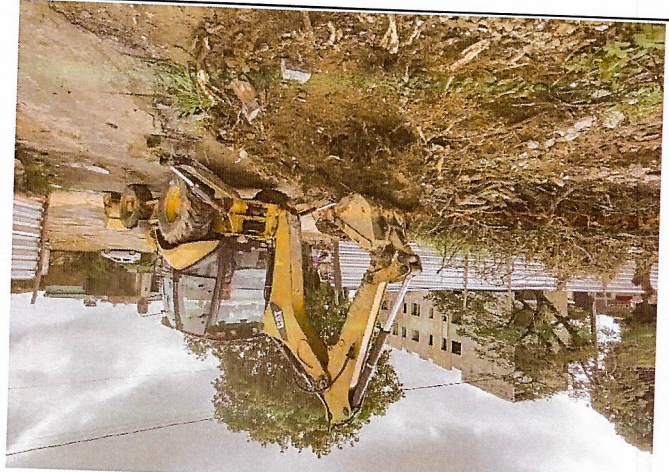
Demolição De Alvenaria Para Qualquer Tipo De Bloco, De Marquise Forma Mecanizada, Sem Reaproveitamento.
