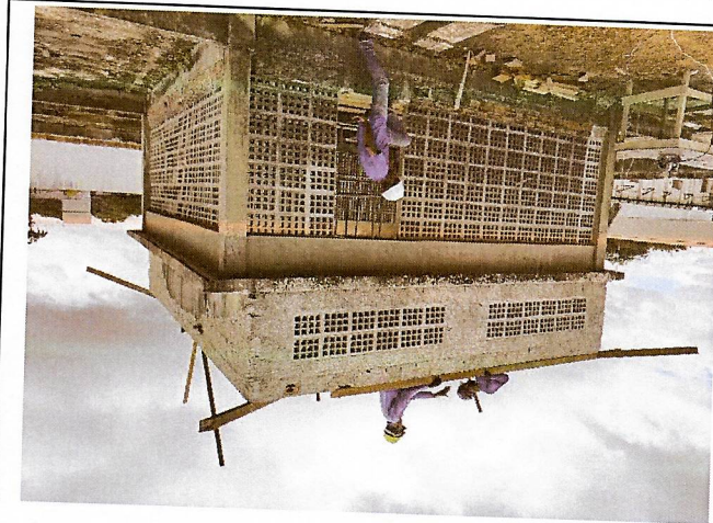
Cobogo de Concreto (Elemento Vazado), Assentado Com Argamassa Traco 1:4 De Cimento E Areia
