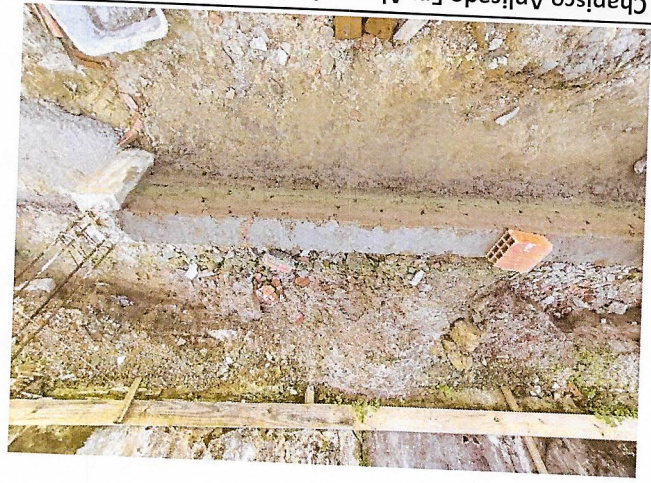
Chapisco Aplicado Em Alvenarias E Estruturas De Concreto Internas, Com Colher De Pedreiro.
