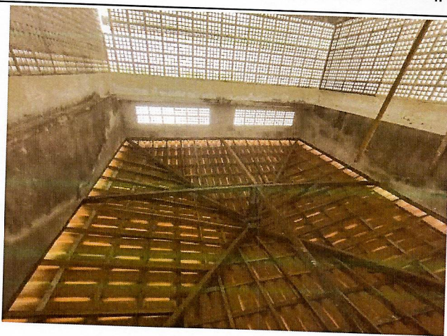
Telhamento Com Telha Cerâmica Capa-Canal, Tipo Colonial, Com Mais De 2 Aguas, Incluso Transporte Vertical.
