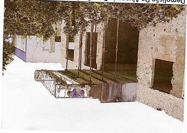
Demolição De Alvenaria Para Qualquer Tipo De Bloco, De Marquise Forma Mecanizada, Sem Reaproveitamento.
