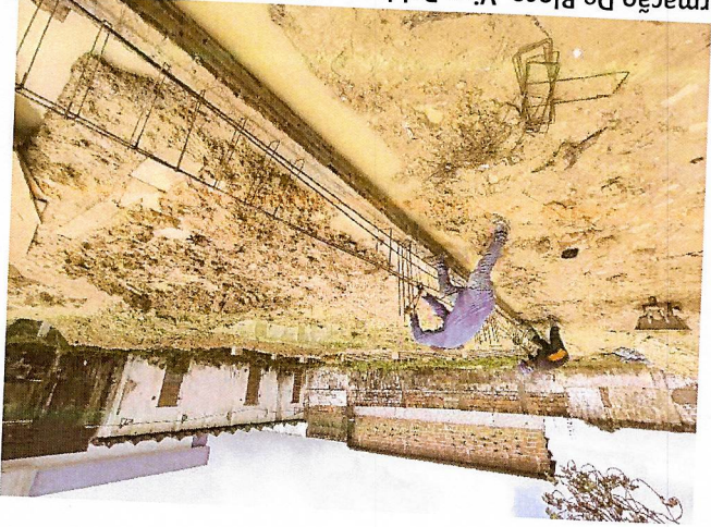
Aterro Manual De Solo E Compactação Mecanizada, Exclusivo Material
