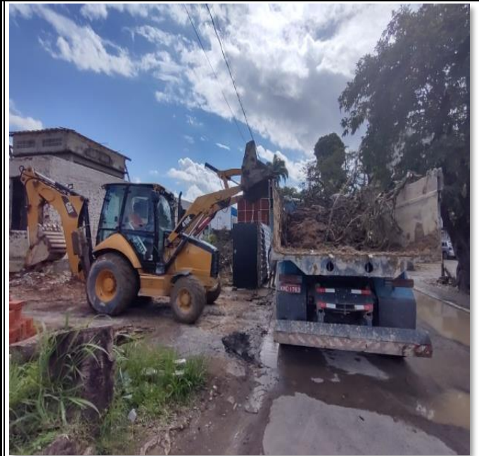
Transporte com caminhão basculante de 10 M 3 , em via urbana pavimentada, Dtm até 30km
