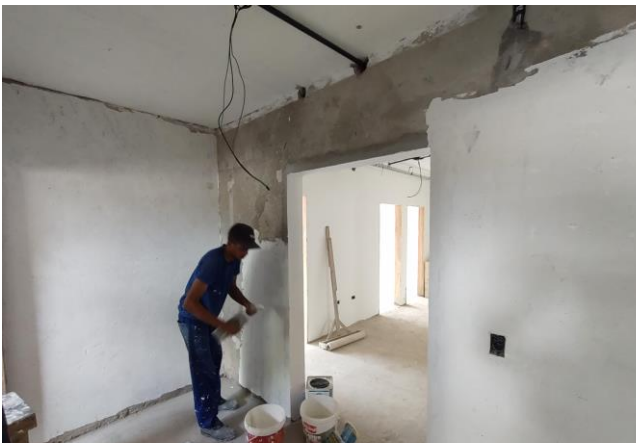
(Eletroduto rígido roscável, PVC, Dn 40 Mm (1 1/4) para circuitos terminais, instalado na laje (fornecimentos e instalação.)
