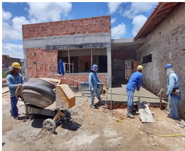
Concreto FcK = 30Mpa, traço 1:2,1:2,5 (Em massa seca de cimento / areia média / brita 1) – preparo mecânico com betoneira.
