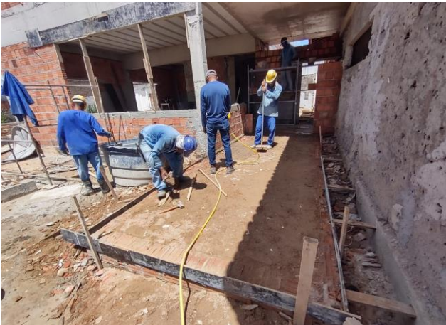
Aterro com areia com adensamento hidráulico
