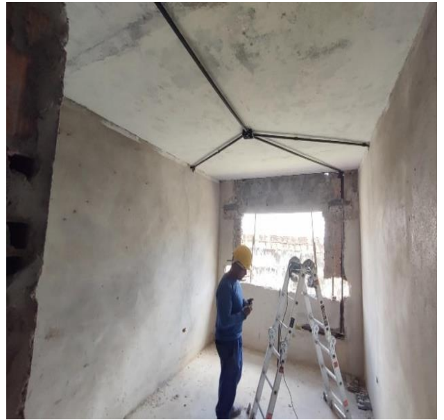
(Eletroduto rígido roscável, PVC, Dn 25 Mm (3/4”) para circuitos terminais, instalado na laje (fornecimentos e instalação.)
