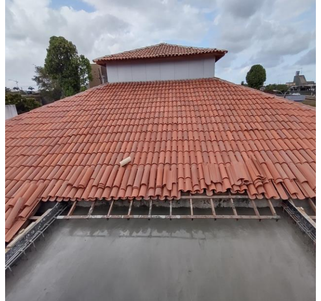
Concreto FcK = 30Mpa, traço 1:2,1:2,5 (Em massa seca de cimento / areia media / brita 1) – preparo mecânico com betoneira
