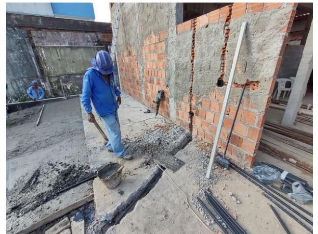
(Eletroduto rígido roscável, PVC, Dn 50 Mm (1 1/2) (fornecimentos e instalação.)
