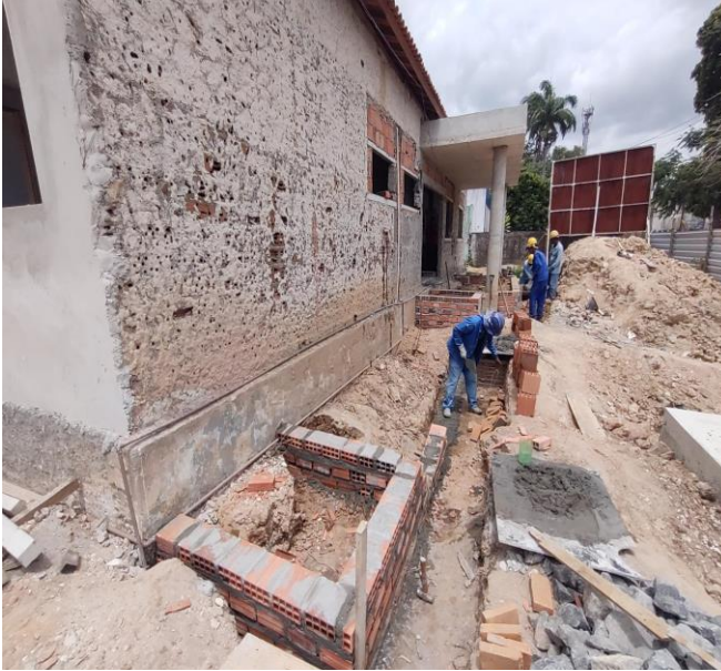
Alvenaria de embasamento em tijolos cerâmicos maciços 5x10x20cm assentados com argamassa.
