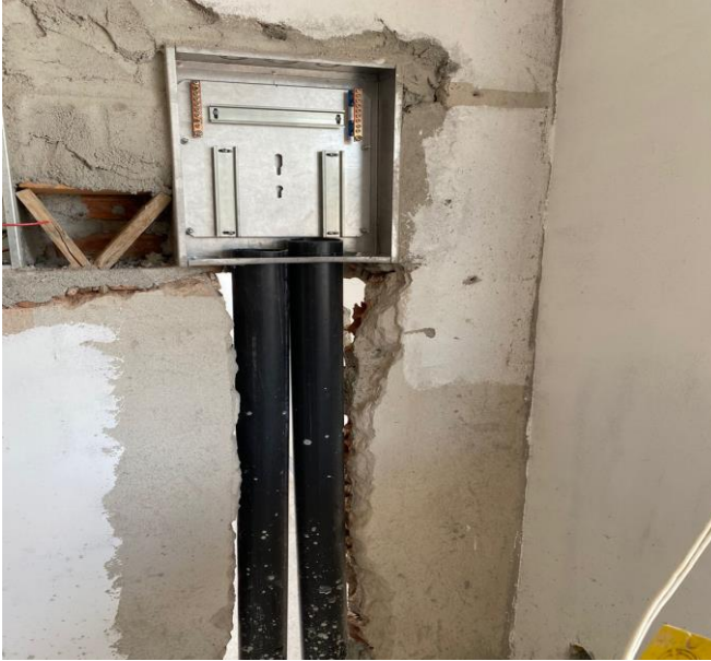
Quadro de Distribuição de Energia em Chapa de Aço Galvanizado, de Embutir, com Barramento Trifásico, para 18 Disjuntores Din 225A (QDG – RECEPÇÃO)
