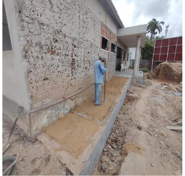
Reaterro manual de valas com compactação mecanizada.
