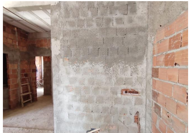
Chapisco aplicado em alvenaria e estrutura de concreto internas, com colher de pedreiro. Argamassa traço 1:3 com preparo manual.
