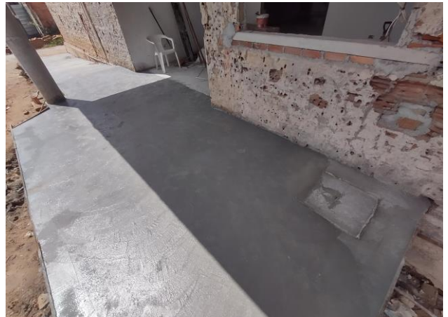
Execução de passeio (calçada) ou piso de concreto com concreto moldado in loco, usinado, acabamento convencional, não armado.
