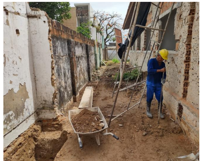
Escavação manual para bloco de concretamento ou sapata com previsão de forma.
