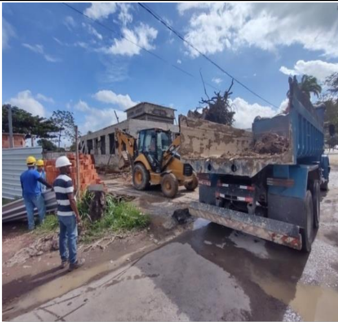
Carga, manobra e descarga de entulho em caminhão basculante 6m 3 - carga com escavadeira hidráulica.
