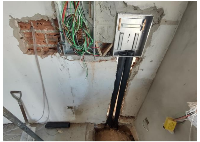
Quadro de Distribuição de Energia em Chapa de Aço Galvanizado, de Embutir, com Barramento Trifásico, para 30 Disjuntores Din 225A (QDG – RECEPÇÃO)
