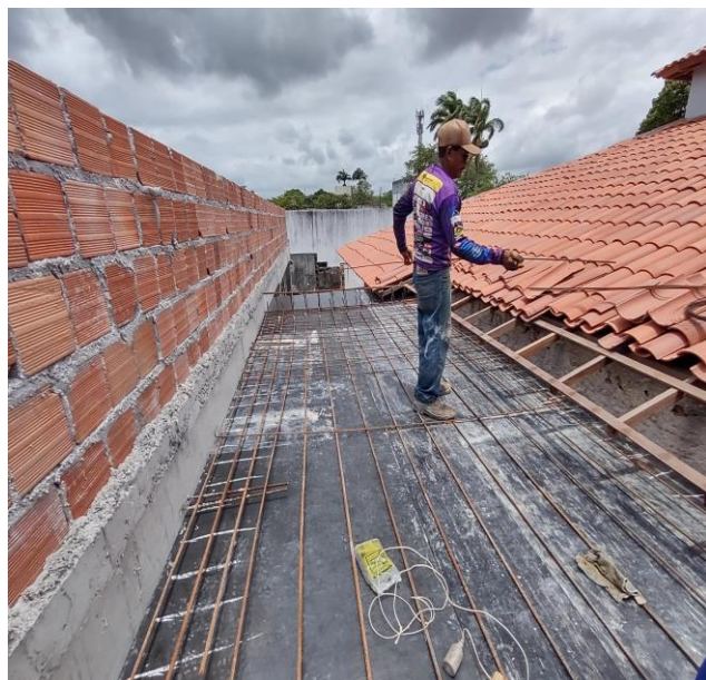
Armação de pilar ou viga de uma estrutura convencional de concreto armado em uma edificação térrea ou sobrado.
