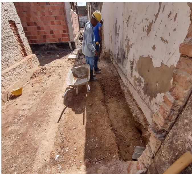
Escavação manual de vala para viga Baldrame, com previsão de forma.
