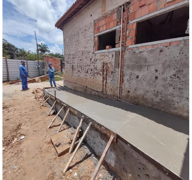
Execução de passeio (calçada) ou piso de concreto com concreto moldado in loco, usinado, acabamento convencional, não armado.
