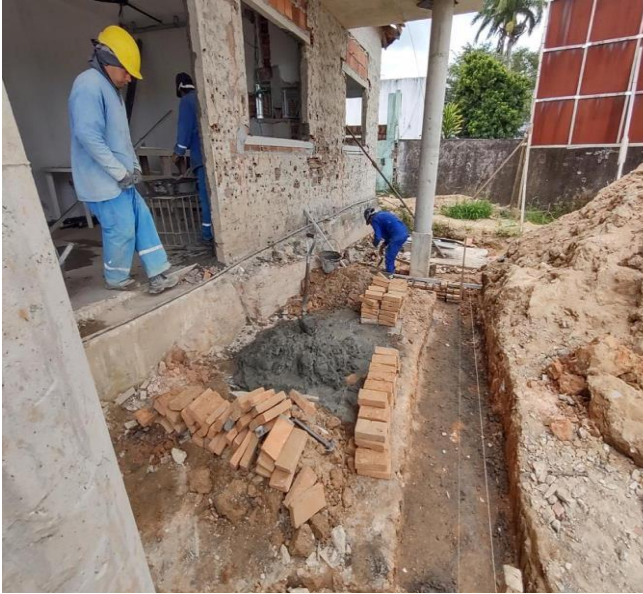
Escavação manual para bloco de concretamento ou sapata, sem previsão de forma.
