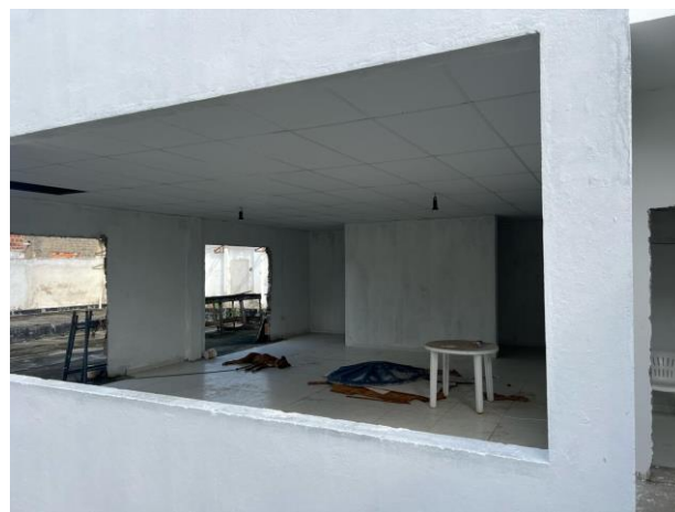
Aplicação Manual De Pintura Com Tinta Látex Acrílica Em Paredes, Duas Demãos. Af_06/2014.
