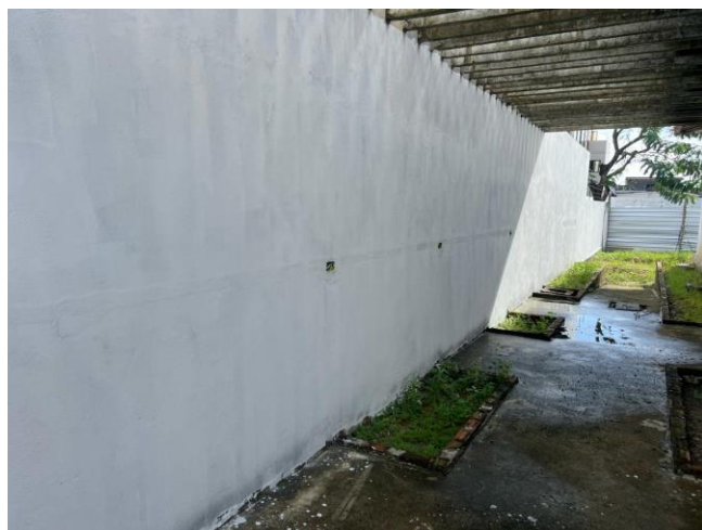
Aplicação Manual De Pintura Com Tinta Látex PVA Em Paredes, Duas Demãos. Af_06/2014
