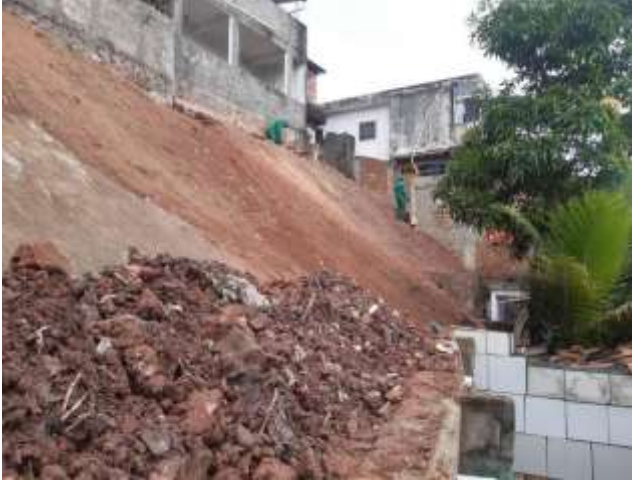
Limpeza manual da barreira 02 na Rua 21 de Abril.
