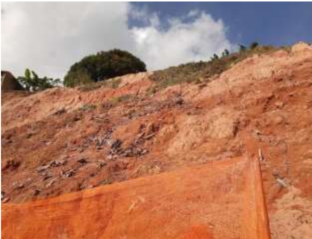
Retaludamento de Aterro na Rua Santo Antônio.
