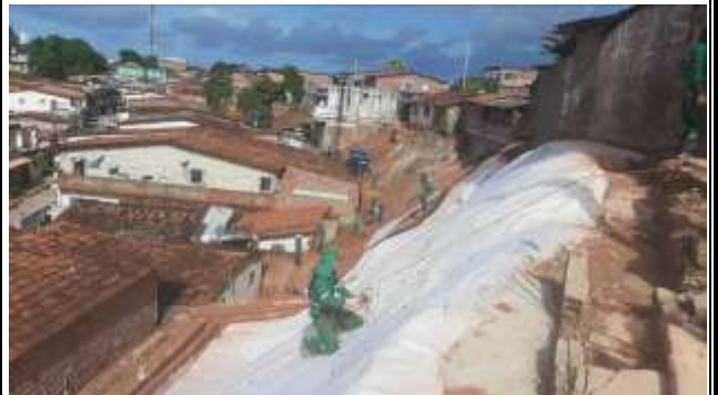
Aplicação de Geocomposto de PVC.
