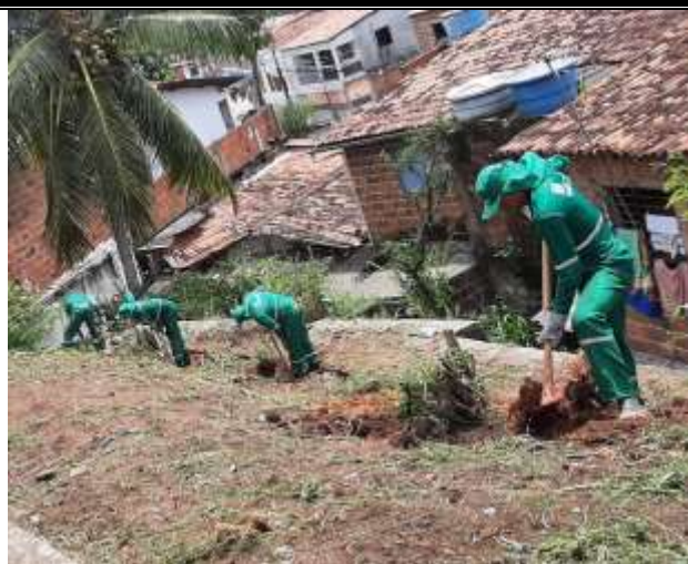
Remoção de raízes - Rua 21 de Abril.
