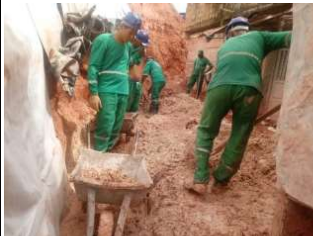
Transporte horizontal de material retirado - Rua Santo Antônio.
