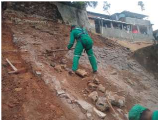
Remoção de Paralelo - Rua 21 de Abril.
