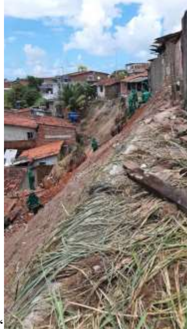
Remoção de raízes - Rua 21 de Abril.
