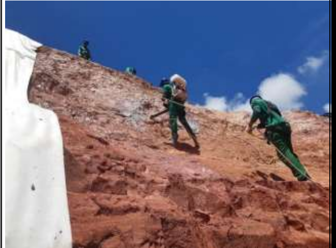
Aplicação de Polímero Acrílico – Rua Santo Antônio.
