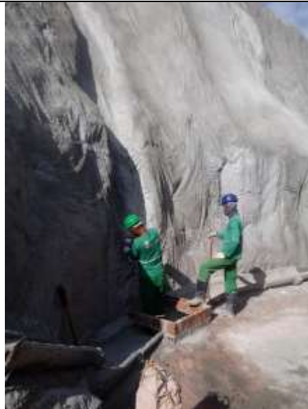
Drenagem com calha pré-moldada tipo meia cana – Rua Santo Antônio.
