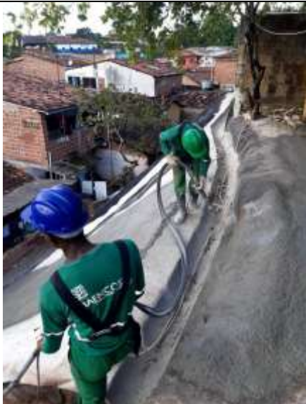
Drenagem com calha pré-moldada tipo meia cana – Rua 21 de Abril.
