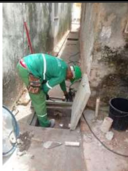
Caixas de Passagem – Rua Santo Antônio.
