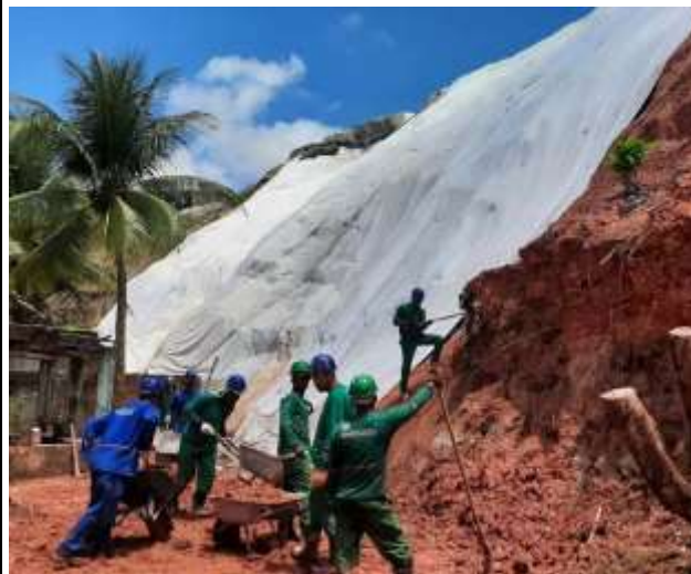
Aplicação de Geocomposto PVC – Coqueirinho.
