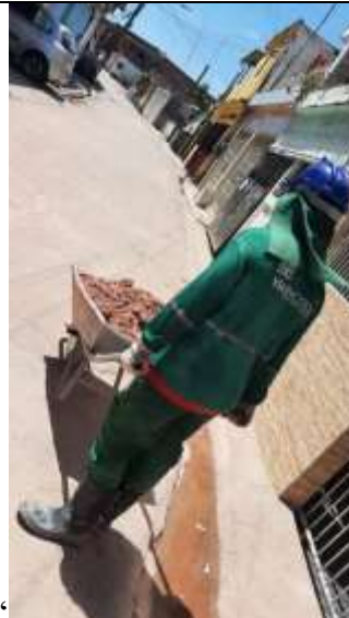
Remoção de material retirado da barreira - Coqueirinho.
