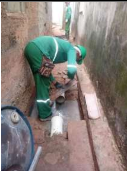
Assentamento de tubos de 150mm – Rua Santo Antônio.
