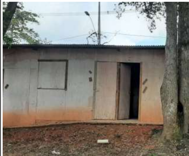
Sanitário e Vestiário.
