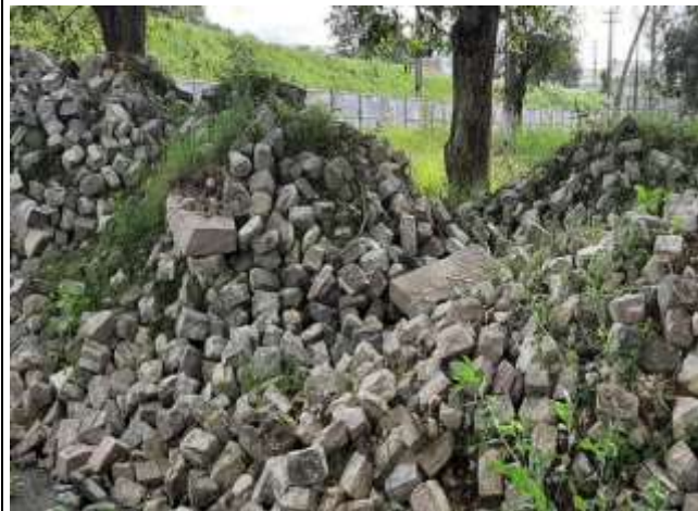
Demolição de Paralelo granítico e meio-fio.
