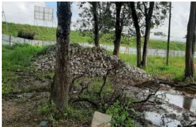
Demolição de Paralelo granítico.
