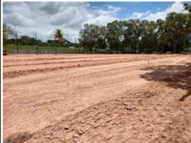
Execução e compactação de aterro.
