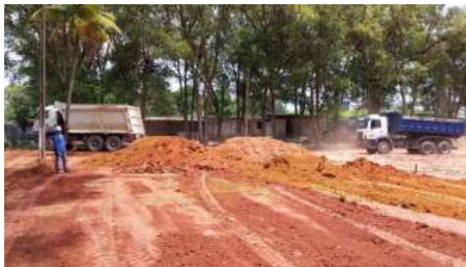
Execução e compactação de aterro.
