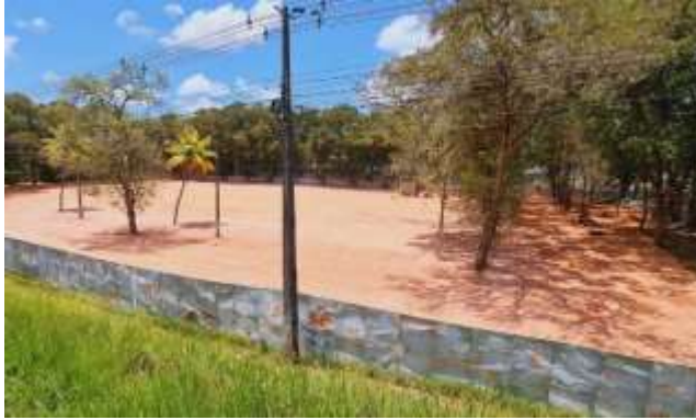
Compactação de aterro.
