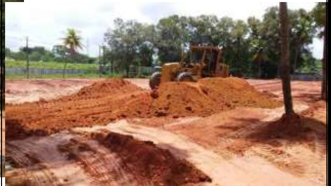
Espalhamento do material com trator esteira
