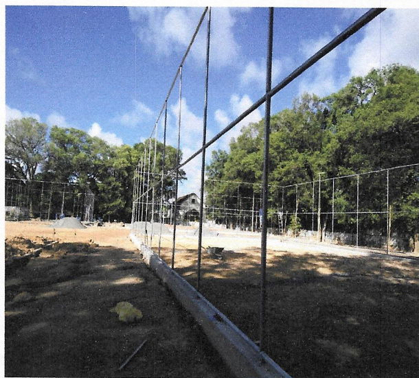
5.18 – Alambrado da quadras e campos
