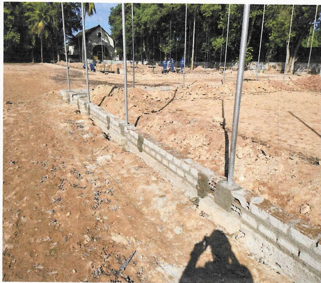
5.16 - Chapisco quadra e campos
