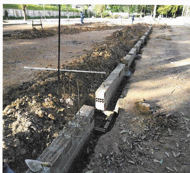
5.14 – Alvenaria fundação das quadras
