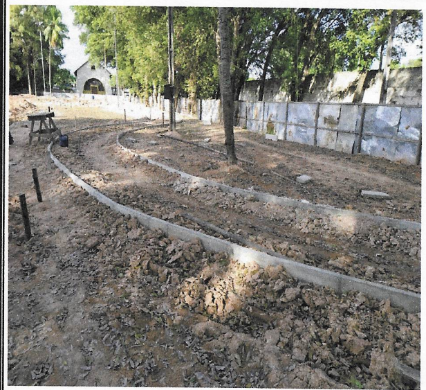
5.9 – Meio fio curvo.
