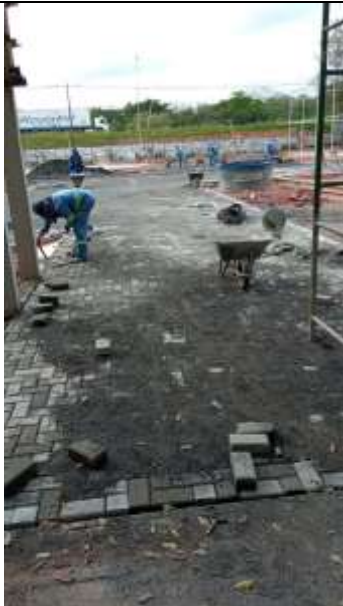
Execução de passeio em piso intertravado.
