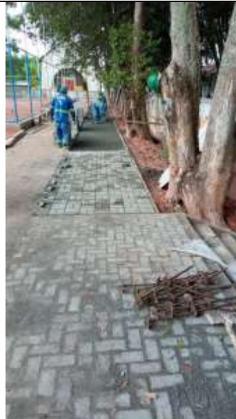
Execução de passeio em piso intertravado.
