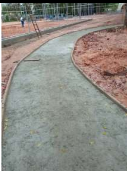
Assentamento de meio-fio da pista de cooper.
