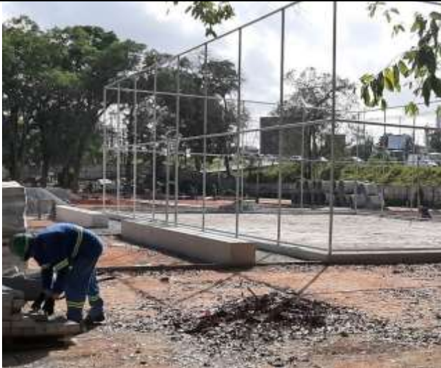
Bancos de concreto ao lado da quadra de futebol de areia.
