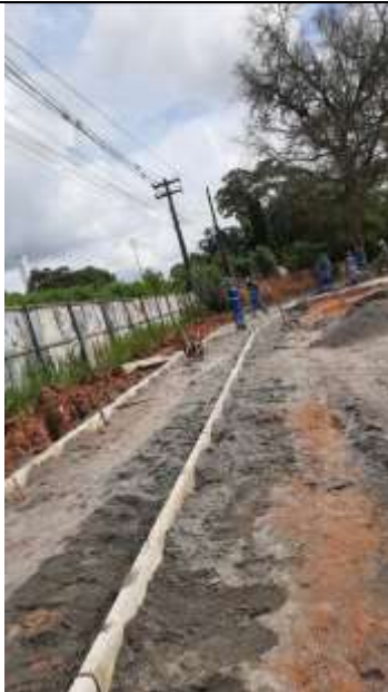
Meio-fio da pista de cooper.
