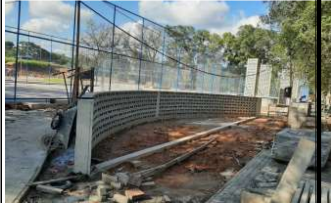
Totem de alvenaria de blocos.
