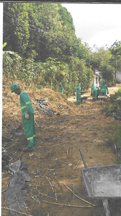
Rua da Barragem – Transporte e remoção de material.
