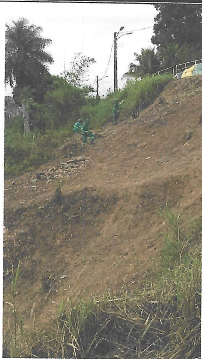
Rua da Barragem – Limpeza do Talude.
