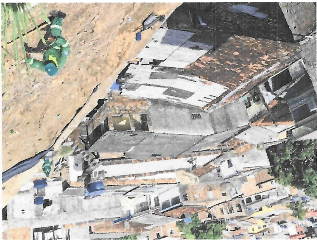
Rua da Barragem – Regularização manual do talude.
