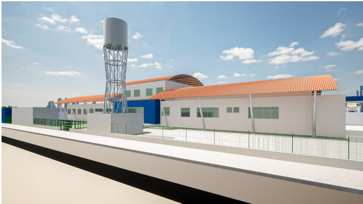
2.2.1 - Fachada Frontal e Lateral Esquerda
